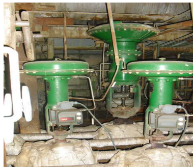
Figura 3. Válvula de regulación tipo DVC 6010 FIELDVUE FISHER (TV601).
